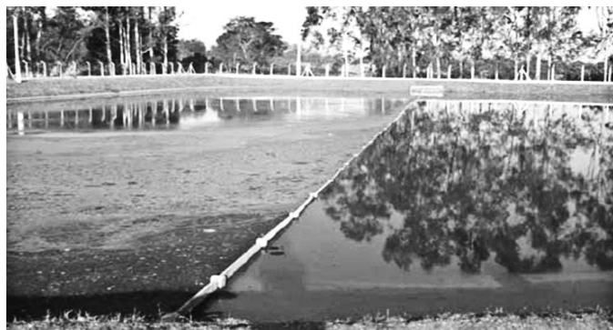
Figura 6. Fotografía de la acumulación de sólidos flotantes en la celda 1 de la laguna anaerobia.
