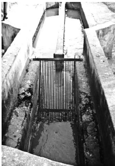
Figura 2. Fotografía de la primera rejilla y el desarenador de dos cámaras. Fuente: los autores.
