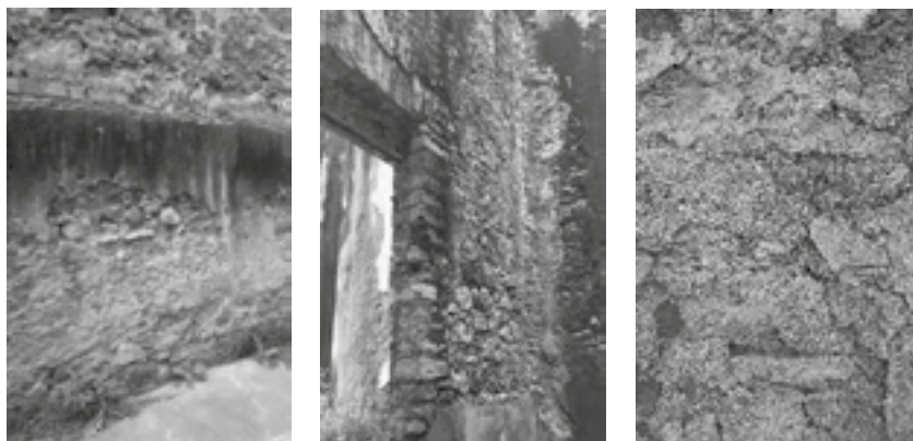
Figura 9. Mamposterías combinadas en muros externos del Templo de San Agustín.
