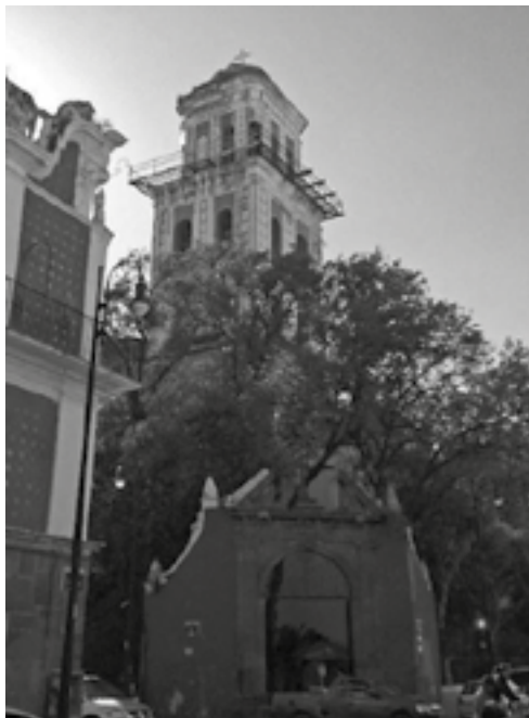
Figura 7. Torre del Templo de San Agustín, ubicado en la ciudad de Puebla.
