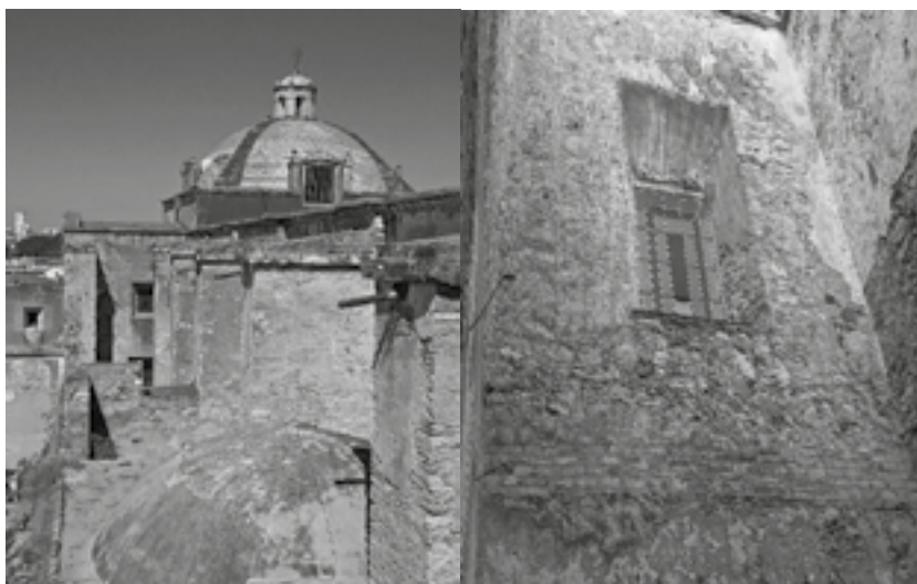
Figura 8. Vista lateral izquierda del Templo de San Agustín y muros del patio.
