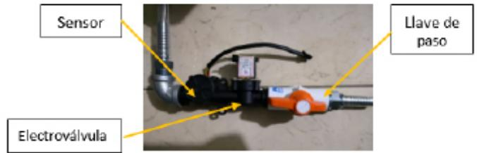
Figura 6. Electroválvula, sensor de flujo y llave de paso.
