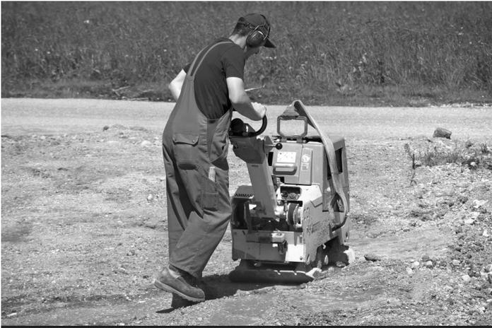
Figura 6. Vibración.
